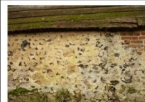
enduit à pierres vues
