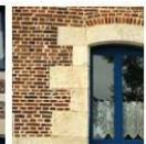
Encadrement de baie en briques en terre cuite et joints de mortier de chaux
