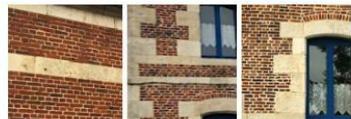
Bandeaux en briques en terre cuite et joints de mortier de chaux
