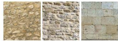
Opus incertum Moellons équarris Pierre de taille grès ou calcaire
