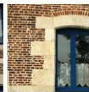
Encadrement de baie en briques en terre cuite et joints de mortier de chaux
